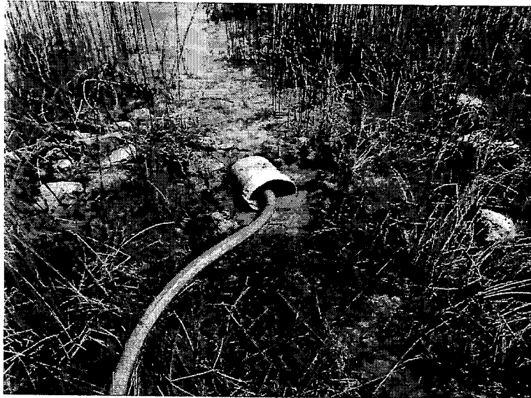
Photo 7: Trou creusé afin de mettre le seau dans lequel il y a la crépine
