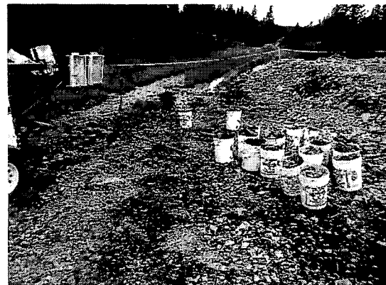
Photo 4 béton ramassé et mis dans des sots
